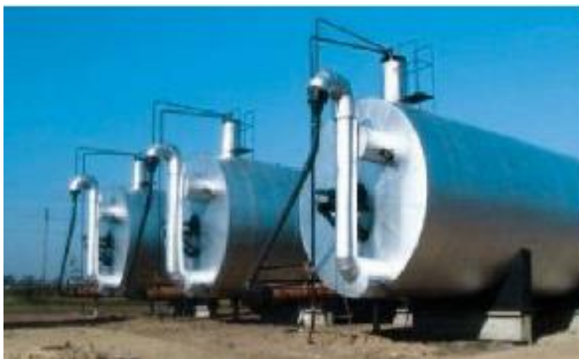
Рисунок 3 - Зовнішній вигляд біогазової установки
